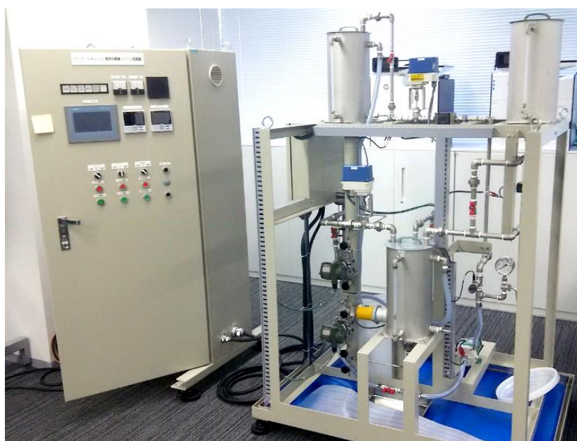
図 2-2 演習で利用する模擬プラント（産業サイバーセキュリティセンター事業案内より引用）
